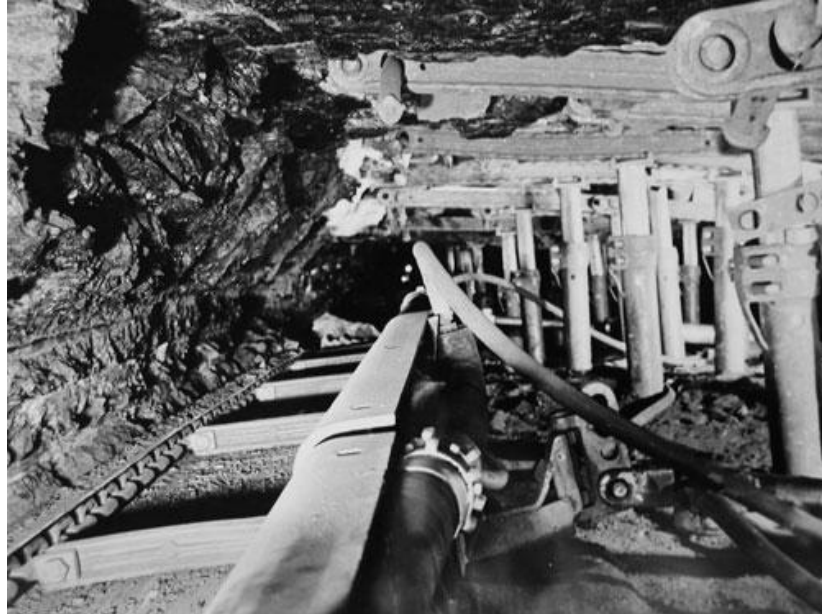
Reissshakenhobel mit Panzerförderer. Ab dem 30.4.1959 in Hausham im Einsatz.
