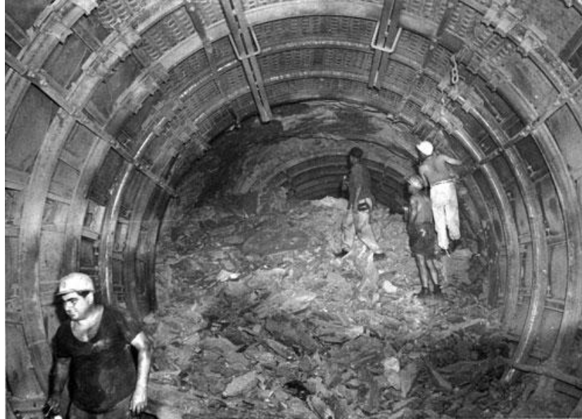
Durchschlag der untertägigen Verbindung Peissenberg - Hohenpeissenberg.
