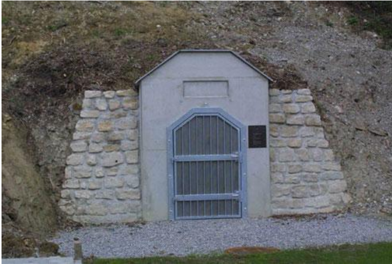
Das Stollenmundloch des Unterbaustollen nach der Renovierung.
