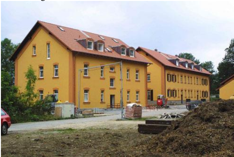
Die ehemaligen Beamtenhäuser am Unterbau, Hohenpeissenberg.
