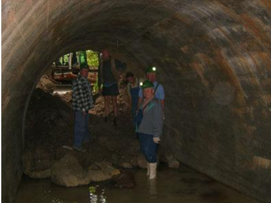
Aufwältigungsarbeiten am Deisenrieder Stollen
