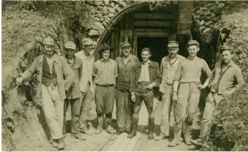
Das Hauptmundloch des Deisenrieder Stollen während der Bauzeit mit einer Schichtbesetzung.
