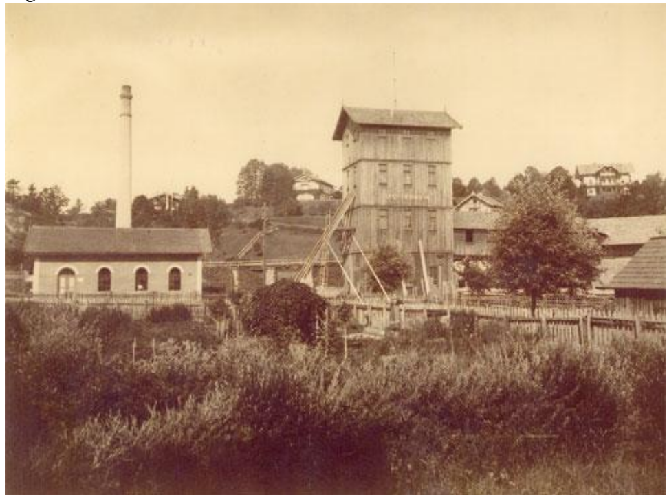
Knorr-Schacht, 34 Meter tief auf den heutigen Parkplatz mit Eissport-halle, (Originalfoto Bergbaumuseum Hausham).
