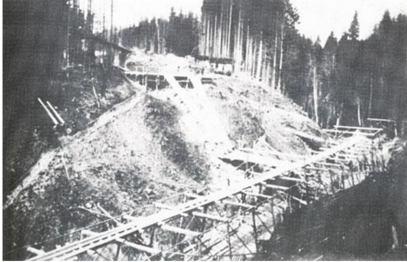
Brückenbau über den Eierbach, Eisenbahnlinie Peissenberg-Schongau.
